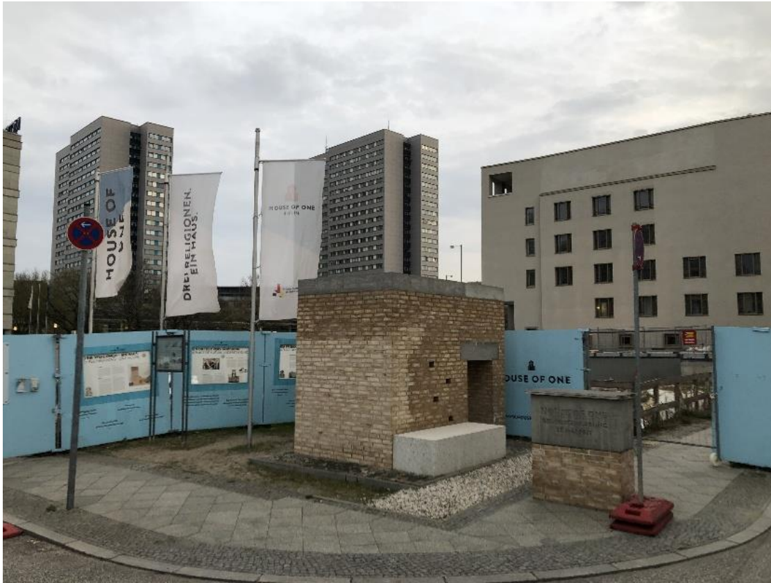
Abbildung 3: Blick auf Bauplatz des „House of One“ mit Grundstein im Jahr 2021 in Berlin-Mitte am Petriplatz (Bild: Krs 2024)
